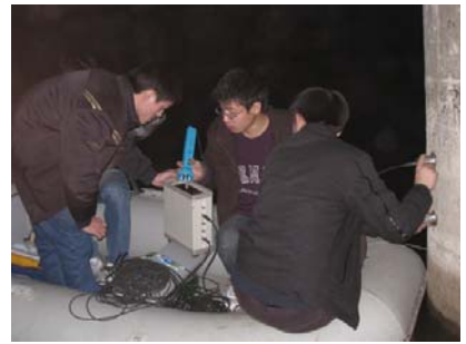
裂缝深度测试
