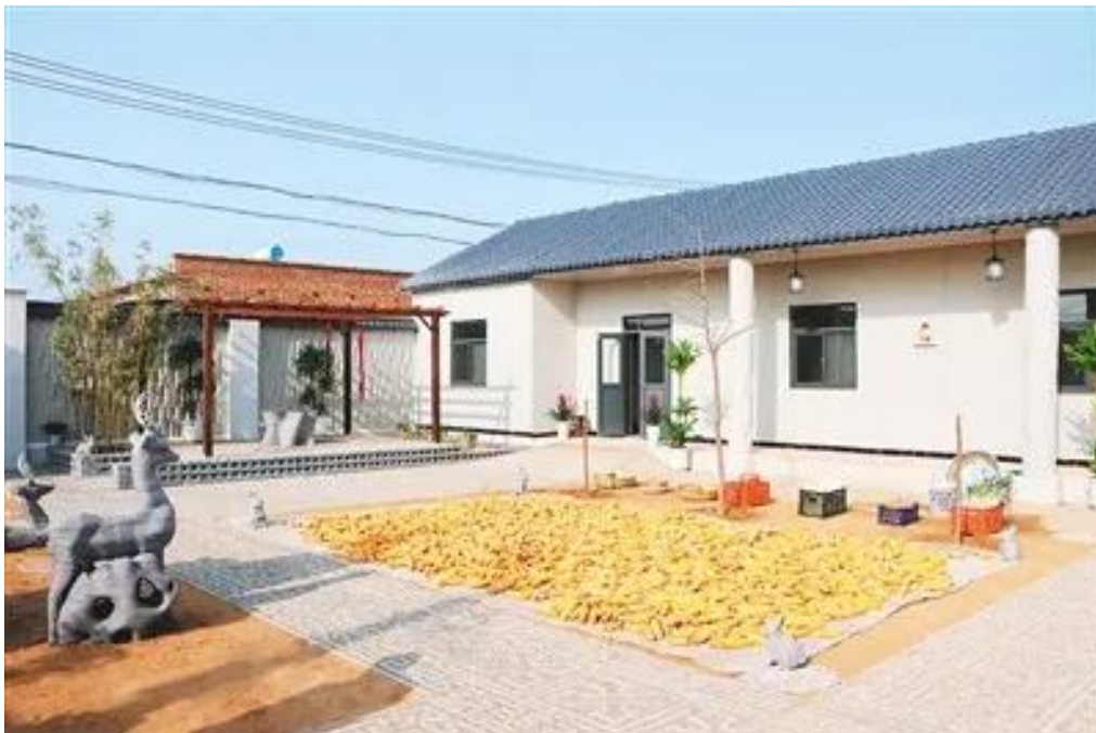
位于河北省故城县的 3D 打印民居（人民日报记者 康朴摄）
