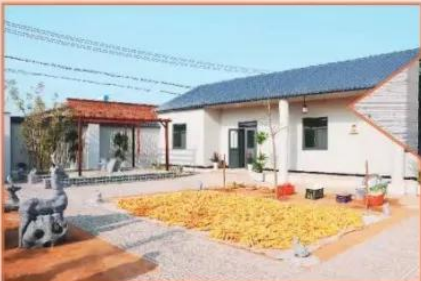
位于河北省故城县的3D打印民居。
