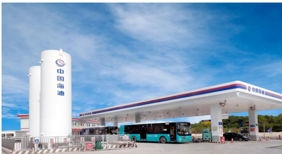
气电集团位于深圳的天然气加注站
