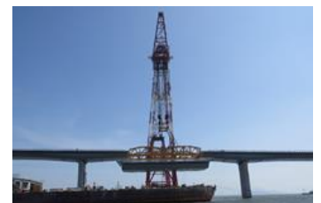
钢箱梁桥位吊装
