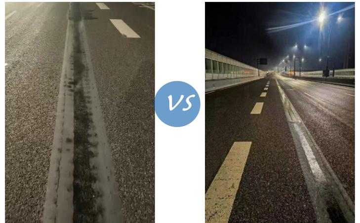
改造原因：拼接缝使用TST材料出现开裂、破损、拥包现象。
