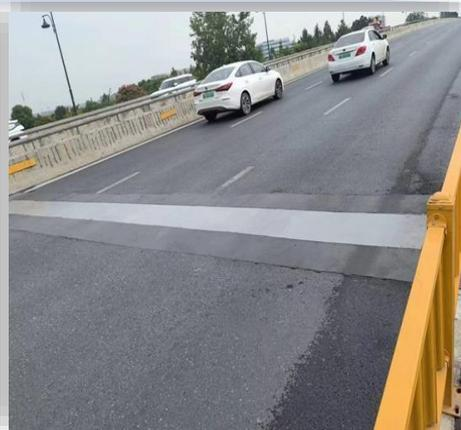
**改造原因：**伸缩缝梳齿钢板松动(异响)、缺失、过渡砣破损
