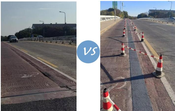
改造原因：拼接缝使用TST材料出现打滑、破损、拥包现象。
