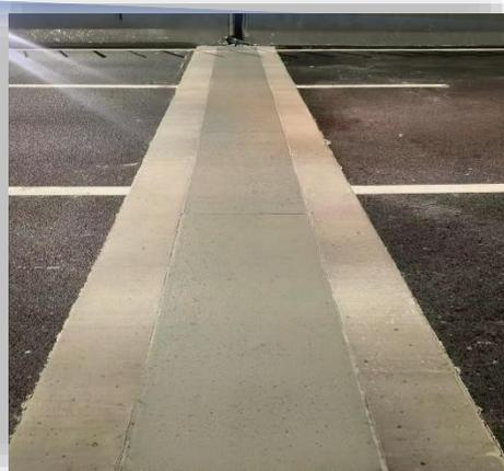
**改造原因：**伸缩缝缝宽达11厘米，行车跳车，噪音大
