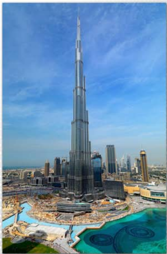
图1 世界最高建筑：828米的迪拜塔
