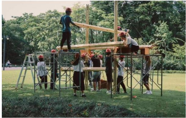
为了让装置的整体比例更加协调，同学们将4根4米长的木头组合成一条杆件。重量的增加对拉索连接处节点的可靠性造成了极大的考验，同时也放大了误差，对杆件加工的精度提出了更高的要求，使得《Floating Link》前几次搭建失败。
